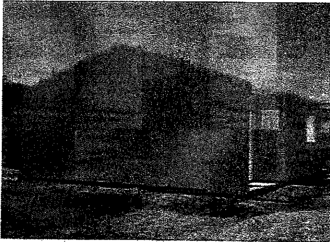
FIGURA 14 – Painéis de PVC concretados
